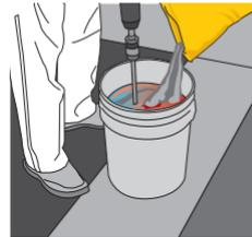
Continúa con los pasos de aplicación dependiendo del tipo de resina, agregando el **comp B** y mezclando\*\*.
