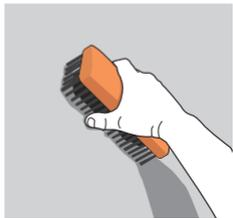
El piso y/o recubrimiento cerámico a emboquillar debe estar limpio, libre de polvo, grasa o cualquier material que impida la adherencia del producto.
