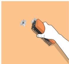
Limpia la superficie. Elimina polvo, partes mal adheridas y restos de pintura.
