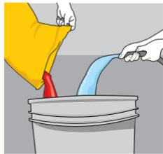
Coloca en un recipiente  $\frac{3}{4}$  del agua total de mezcla y agrega poco a poco el **Sikalastic®-1c** (polvo). Mezcla con taladro por unos minutos hasta obtener una pasta uniforme.
