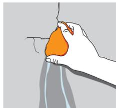
Introduce la pasta rápidamente en la grieta o agujero, y sostén fuerte para vencer la presión del agua hasta que la pasta endurezca.
