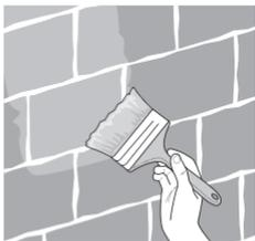
Agita **Sika® Zero Salitre** y aplica la 1ra. capa con brocha o rodillo. Deja secar de 2 a 3 hrs. Si el aplanado esta dañado, retíra.
