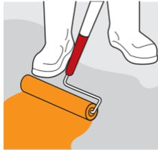
Aplica un primer: Mezcla una parte de **Acril Techo® 005 Iron Home** con 3 partes de agua (mezcla en volumen), aplica con rodillo o brocha y deja secar de 2 a 4 hrs.
