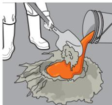
Después agrega **Sikanol®-M** más **Sika® Tard-E** disuelto en el 20% restante de agua, mezcla de 2 a 3 min. hasta obtener la consistencia deseada y aplícala.
