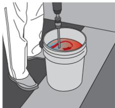
Mezcla durante 1 minuto con un taladro de bajas revoluciones el componente A (300-400 rpm) hasta homogeneizar la mezcla y color. No agregues burbujas a la mezcla.
