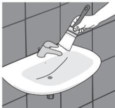
Limpia la superficie o bordes de la unión o junta dejándola secar y que esté sin restos de polvo o material desprendido.
