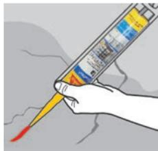
**Aplica un primario:** Mezcla una parte de **Acril Techo® POWER** con 3 partes de agua, aplica con rodillo/brocha, dejar secar de 4 a 8 hrs. Importante: Para sellar grietas mayores a 1 mm, antes de impermeabilizar usa **Sikaflex® -1a**.
