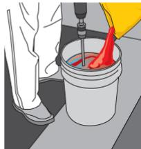
Coloca agua en un recipiente (máximo 5.75 L) y vacía gradualmente **SikaScreed® 80 Mortero Nivelador**. Mezcla con taladro de bajas revoluciones\*\*.
