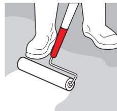
Aplica la siguiente capa de **Sikalastic® 570 TC** a razón de  $0.5 \text{ L/m}^2$  de forma perpendicular a la capa anterior. Si deseas mayor durabilidad (15 años) aplica una tercera capa de **Sikalastic® 570 TC** a razón de  $0.5 \text{ L/m}^2$ .
