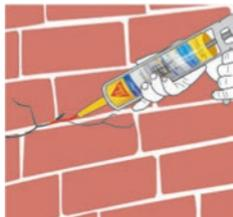
Repara las grietas con Sikaflex® 1a y los descascaramientos con SikaTop® 122.
