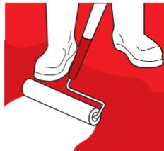
Aplicar una segunda capa de **Acril Techo® Rápido** perpendicular a la primera y a razón de 0.5 mm por capa. Dejar secar 2 horas.
