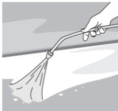
Continúe agregando agua hasta que la pasta retardada haya sido removida de la superficie y el agregado ya se encuentre expuesto.
