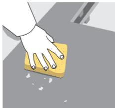
Limpia la superficie, debe estar seca y sin restos de polvo o material desprendido. Si existen fisuras sobre la superficie, deberán de sellarse utilizando **Permalastik®** a lo largo de la fisura.
