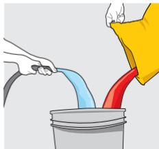
Coloca 2.6 L de agua en una cubeta limpia y agrega **Sikaquick®** gradualmente mientras mezclas con taladro de bajas revoluciones.
