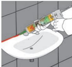
Rellena la junta con **SikaSeal®-113 Universal** evitando atrapar aire y la formación de burbujas. Aplica un cordón de 6 mm de lado de la unión.
