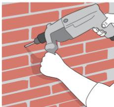
Perforar en todas las intersecciones del ladrillo a 15 cm sobre el suelo de forma horizontal.
