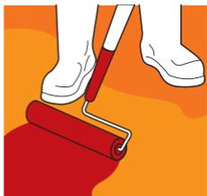
Como acabado: Aplica 1 ó 2 capas de **Sikafloor® 161** pigmentado, utilizando un rodillo de felpa de pelo corto de 3/8" resistente a solventes.
