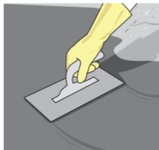
Vaciálo sobre la superficie a nivelar y extiéndelo con regla o llana dentada o escantillón<sup>(2)</sup>.
