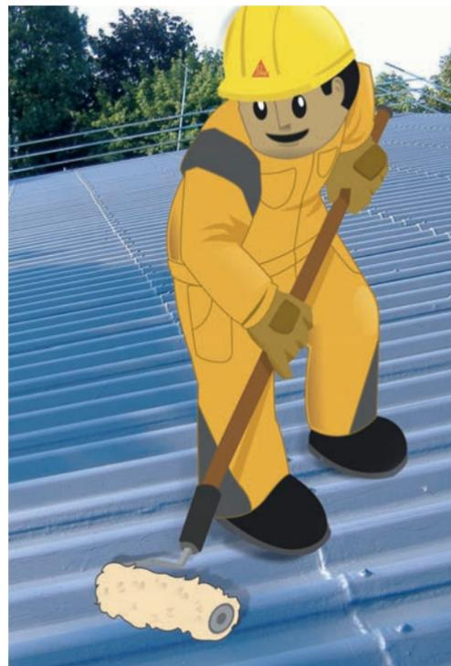
Si se desea dar una protección anticorrosiva a una techumbre de lámina se puede colocar el primario anticorrosivo **SikaCor® Eg Phosphat**, en vez del primario señalado en el paso 2.
