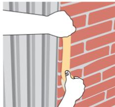
Enmascara los bordes de la junta utilizando cinta adhesiva. Utiliza **Sika® Rod** del diámetro del ancho de la junta a sellar, con el fin de cumplir el factor forma para juntas con movimiento.
