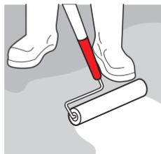
Aplica un primario: Mezcla 1 parte de **Acril Techo Green® POWER** con 3 partes de agua (mezcla en volumen), aplica con rodillo o brocha y deja secar de 4 a 8 hrs.
