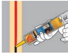
Aplica **Sikaflex®-133 multipropósito** evitando atrapar aire y la formación de burbujas. Aplica un cordón de 6 mm de lado en la unión.
