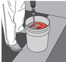
Agrega el pigmento al **comp A** (resina) y mezcla por 2 minutos o hasta homogeneizar con taladro de bajas revoluciones (300-400 rpm).
