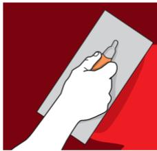
Aplicar la mezcla en el sustrato preparado con un llana metálica lisa. Se pueden aplicar una o más capas dependiendo del acabado deseado. El espesor de aplicación es de aprox. 1 a 2.0 mm por capa.
