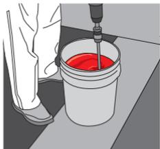
Mezcla manualmente o con un taladro de bajas revoluciones, adiciona el resto del **componente A** hasta obtener una mezcla de color uniforme.
