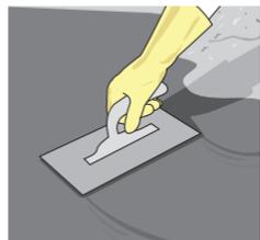
Deja reposar la mezcla por 2 minutos y vierte el producto sobre el sustrato, previamente imprimado con **SikaLatex N** diluido en agua 1:2, extendiéndolo al espesor deseado con llana dentada y alise con flota de magnesio.
