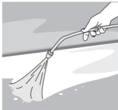
Aplice **Sika® Rugasol S** con un rociador de baja presión inmediatamente después del enrasado cuando el concreto haya perdido su brillo.
