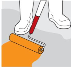
Para mantenimiento: usar como primer **Acril Techo® 3 PRO** diluido con agua 3:1 1 capa de .6 lts/m<sup>2</sup>. (solo paso 1 y 2).
