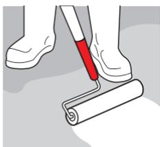
Aplicar una segunda capa de **Acril Techo® Green Power** perpendicular a la primera y a razón de 0.5 mm por capa. Dejar secar 24 hrs.
