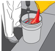
Mezclado de **Sika® Level 125**, adicionar el 18% de agua (4 L).
