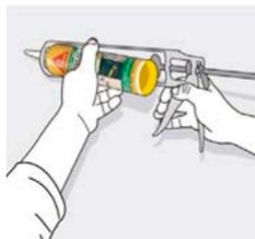
Corta la boquilla en 'V' para aplicar el cordón del adhesivo de forma triangular (8 mm de ancho, 10 mm de largo). Instálalo en la pistola de calafateo.
